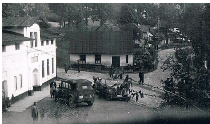
Celnice – bývalá mýtovna ; propustka
